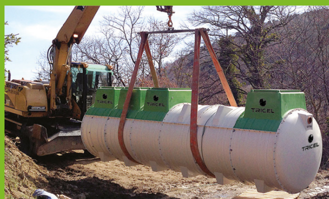
Installation d'une Tricel Novo FR20
