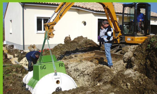
Installation d'une Tricel Novo FR6
